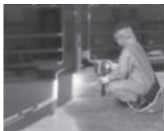
石灰乳の塗布
